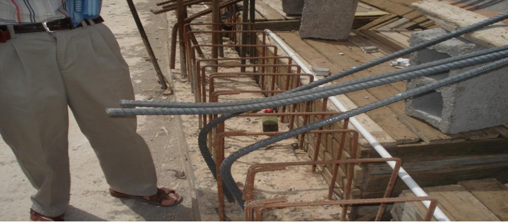
شكل (١٠): عملية ثنية حديد التسليح للجسور
