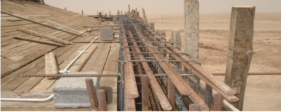
شكل (٩): تسليح الجسر الحمل B12
