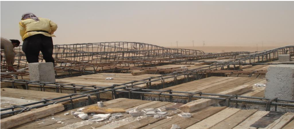
شكل (١١): القالب والتسليح العلوي للمشبك العلوي
